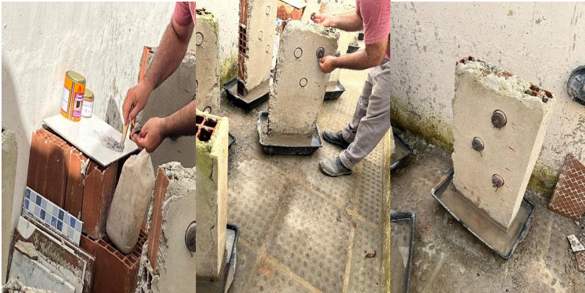
Figura 31 - Processo de colagem dos ganchos
