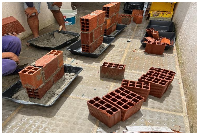
Figura 24 - Assentamento da alvenaria nas argamassadeiras plásticas
