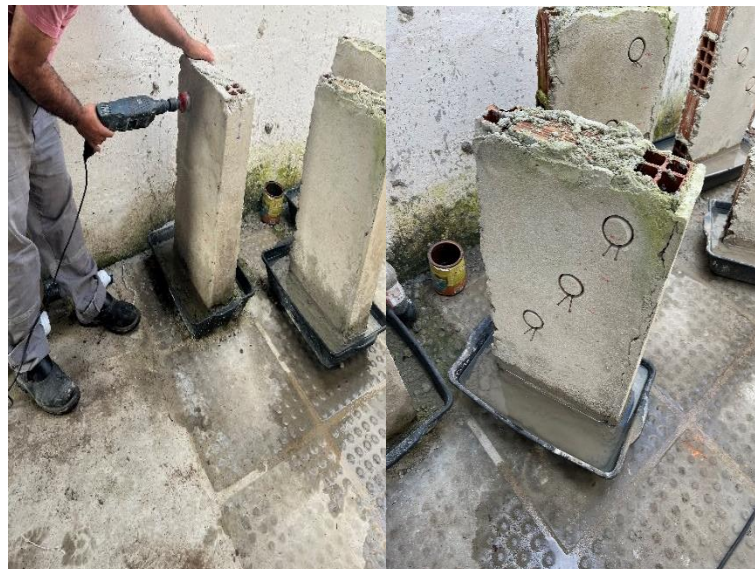
Figura 30 - Realização da marcação e furos dos protótipos
