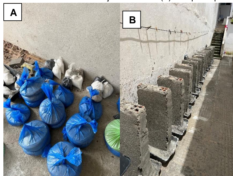
Figura 26 - Materiais utilizados na execução do reboco (A) e os protótipos rebocados (B)
